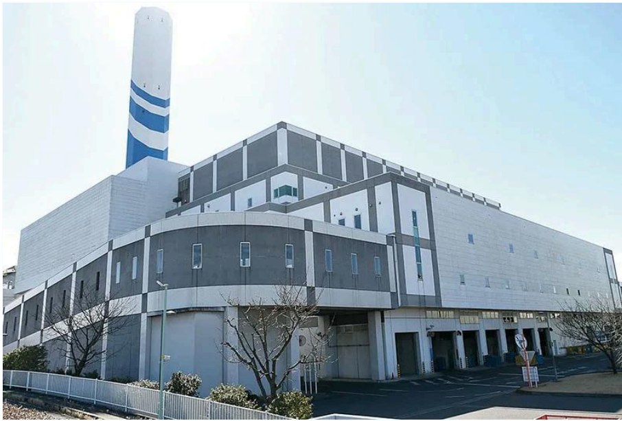
1月3日に発生した火災で施設の一部が損壊し、一般ごみの受け入れを中止している川口市朝日環境センター＝川口市朝日4丁目
